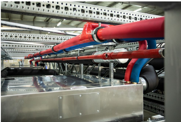
In einer Exyte-Werkstatt montiertes ExyCell-Modul.
