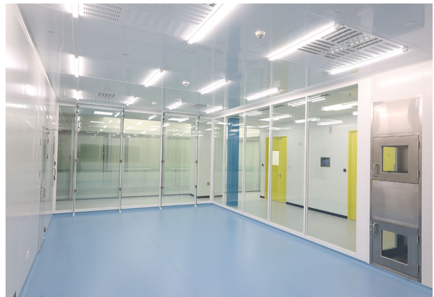
Das ExyCell-Modul am Miltenyi Biotec Standort in Shanghai vor Einbau der CliniMACS Cell Factory.
